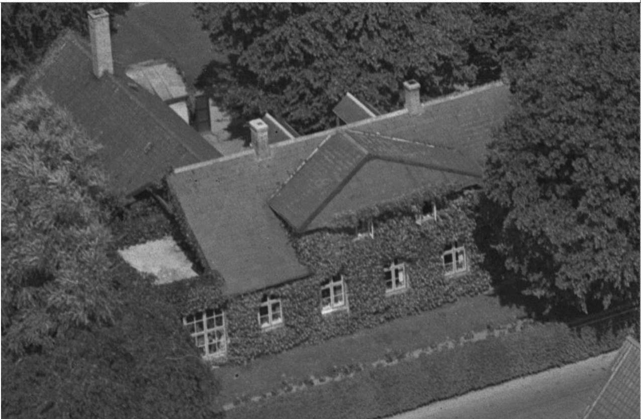
Fåborgvej 22 – 1950 - Kilde: Danmark set fra luften
