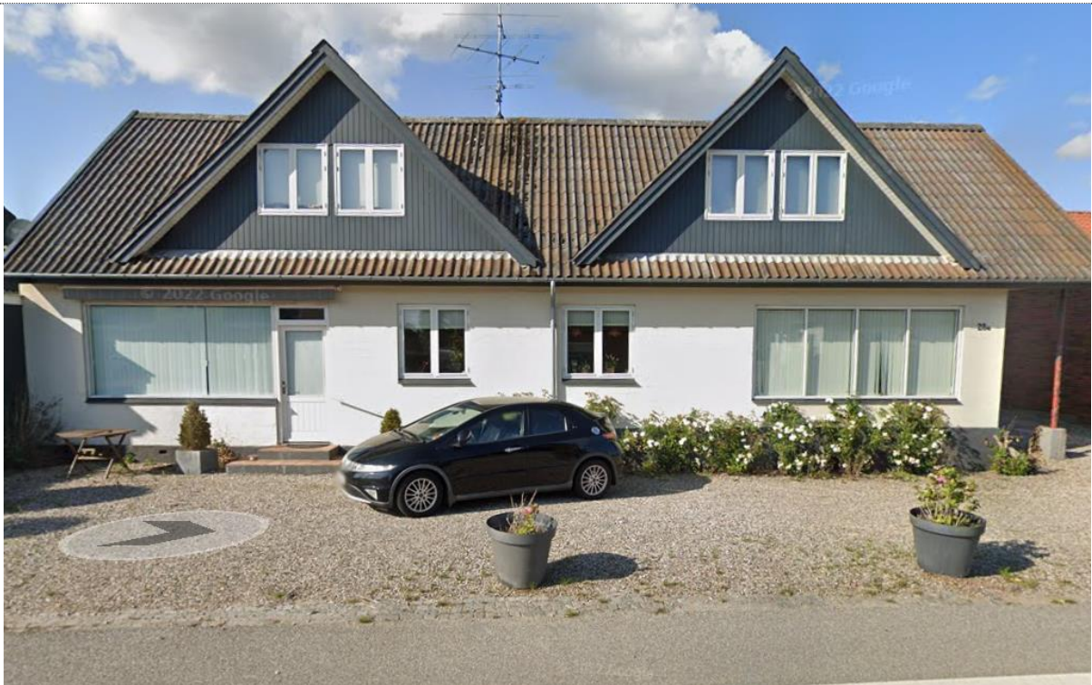
Fåborgvej 28 – ( Fra Google street view )
