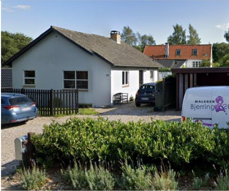
Fåborgvej 3a (i forgrunden) og 3b – ( Fra Google street view )
