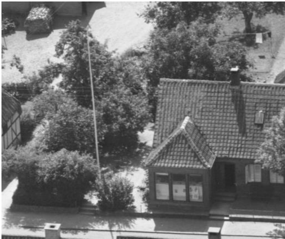
Fåborgvej 5 – 1959 - Kilde: Danmark set fra luften
